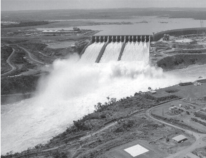
شكل ١-٩: محطة إيتايبو للطاقة المائية على الحدود الواقعة بين البرازيل وباراجواي. بسعة تبلغ 14.0GW، تعد هذه المحطة واحدة من كبرى محطات الطاقة المائية وتنتج نحو 20 بالمائة من كهرباء البرازيل.
